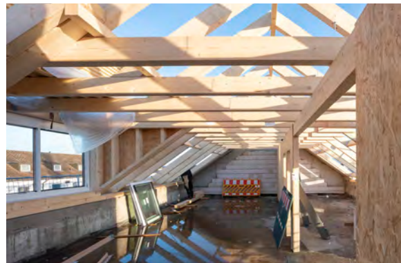
Holzdachaufbau mit ausgearbeiteten Gauben
