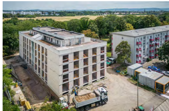
Umbau und Modernisierung eines Wohngebäudes
