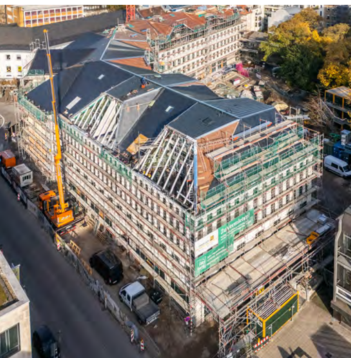
Historischer Bauerhalt in Kombination mit Neubau
