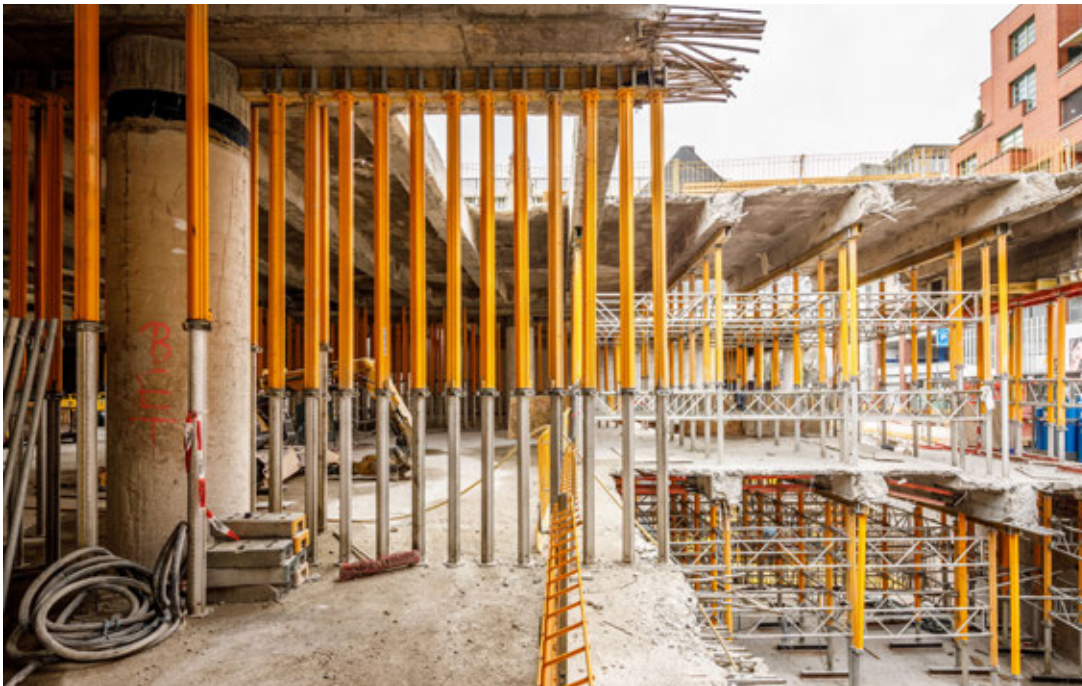
Bauteilerneuerung und Austausch schadhafter Substanz
