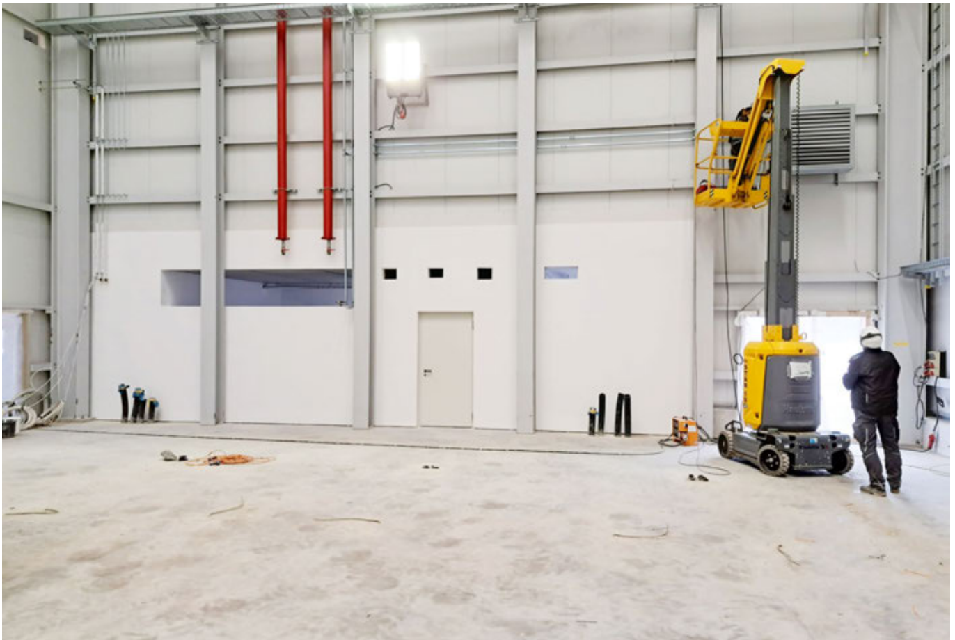
Komplettsanierung von Technik- und Sozialräumen inklusive energetischer Optimierung
