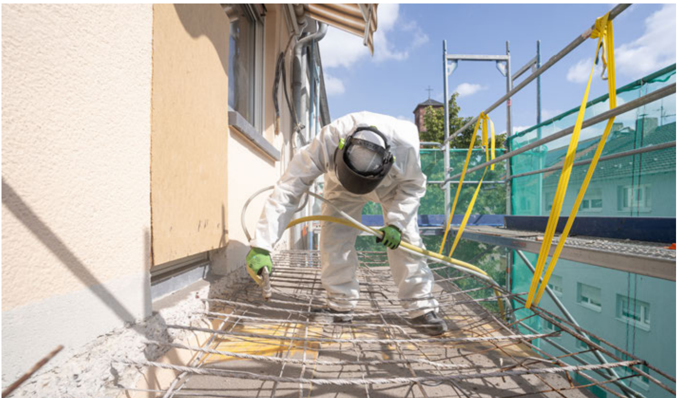
Balkonsanierung – Sandstrahlen der korrodierten Armierung
