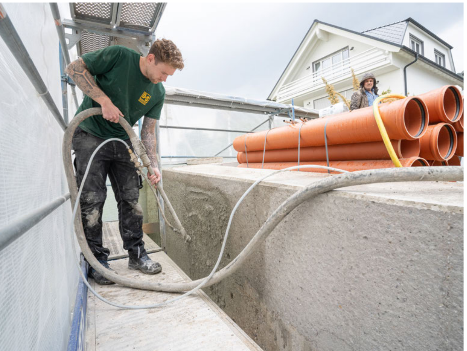
Spritzbeton-Auftrag nach der Aufstockung einer Betonstützwand
