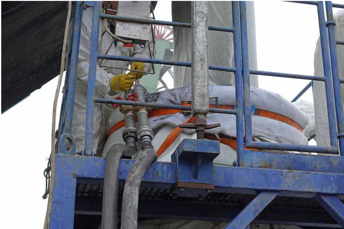
Am Inversionsturm befestigte Schläuche sorgten für eine kontinuierliche Wassereinleitung.
