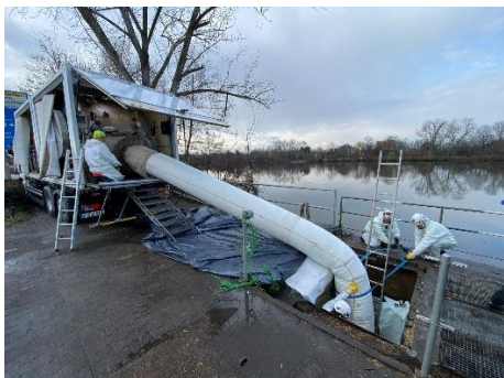
BU: Installation unter erschwerten Bedingungen: Die Inversionstrommel stand im 90-Winkel zur Sanierungsstrasse
