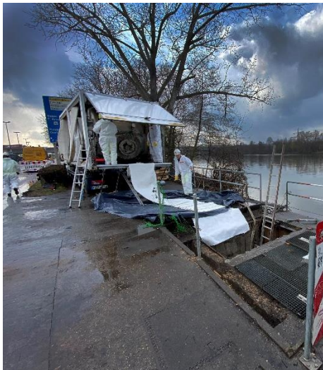
BU: Hier sind Flexibilität und Präzision erforderlich: Sanierung der Saugleitungen am viel befahrenen Mainufer
